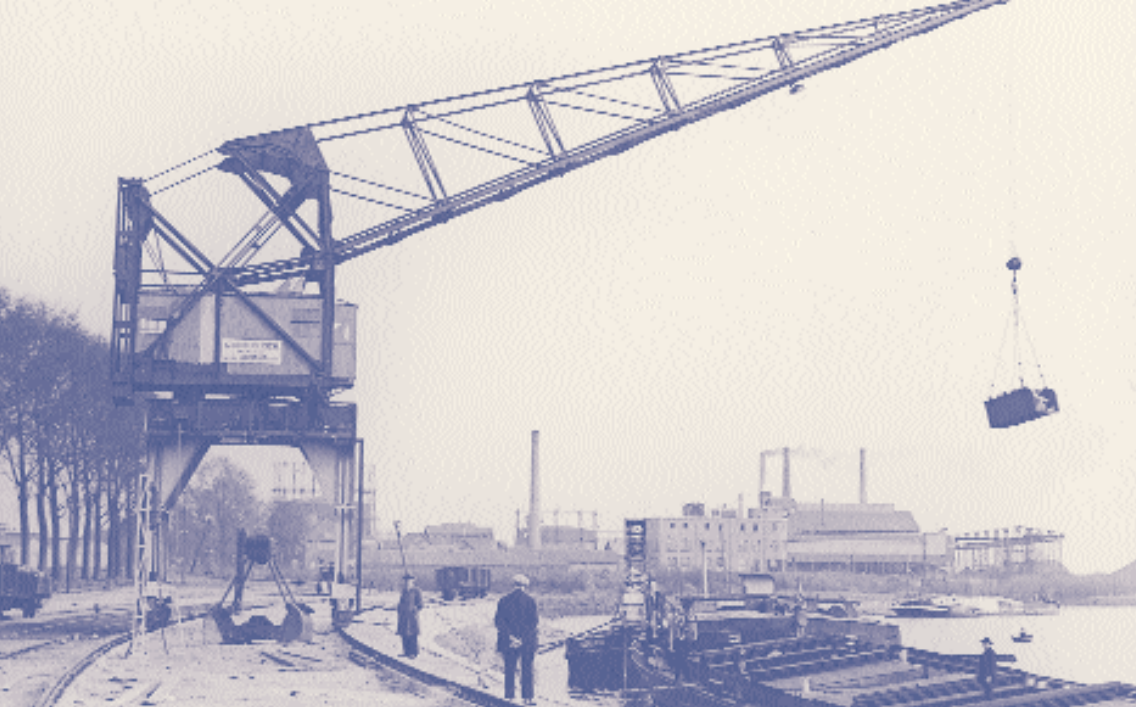
1920, Havenkraan, 3 tons, 21 meter zwaaï
